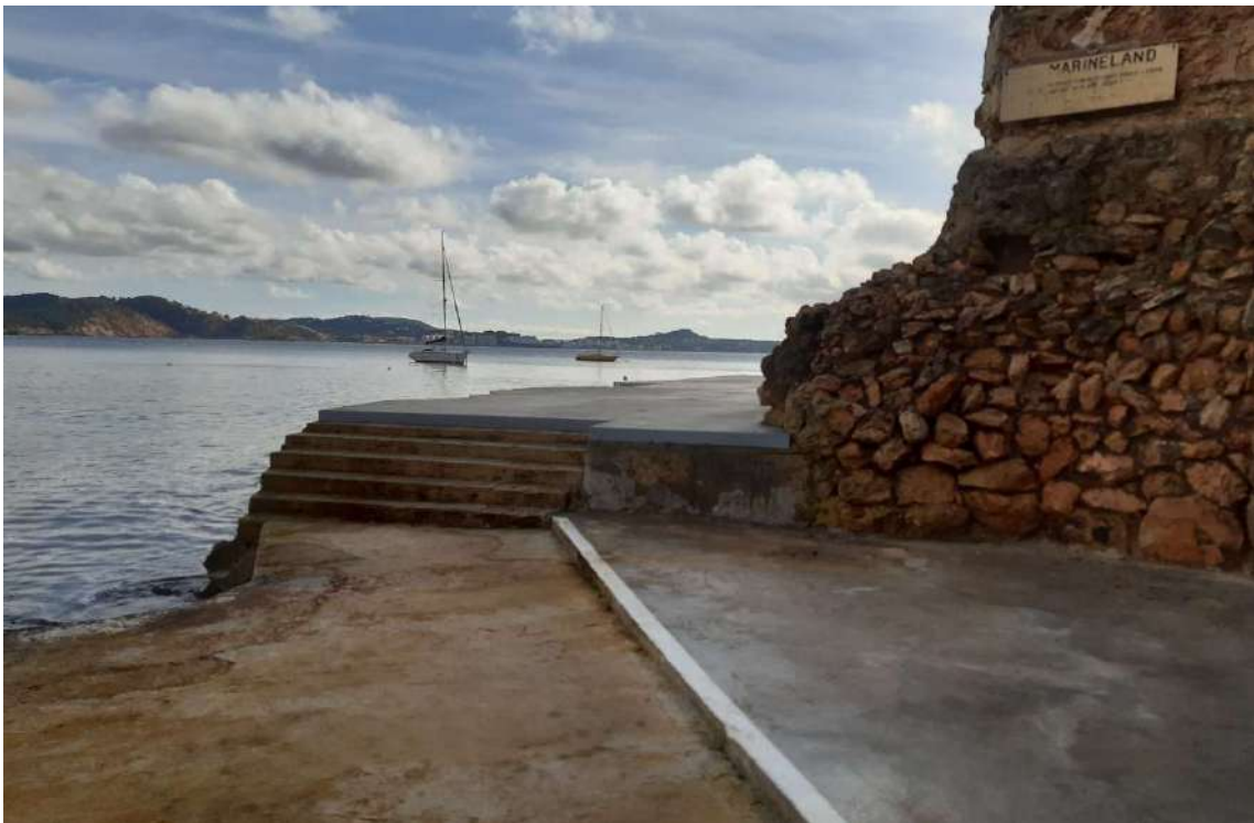
Foto 5. Final de la primera plataforma al mismo nivel y escaleras de acceso a la segunda a cota superior y embarcadero al final de la misma, siendo ésta la única zona donde el paramento vertical va forrado de piedra natural en lugar de marés.
